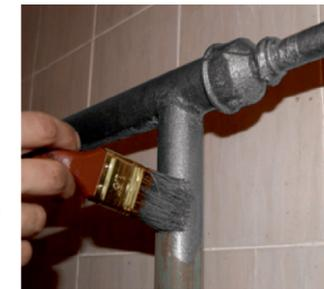
Предназначаются для декоративной окраски поверхностей, а также антикоррозионной защиты металлических поверхностей и конструкций, находящихся в условиях повышенной влажности или в грунте.
