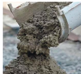
Применяется для любых видов бетона и цементно-песчаных смесей. Используется для приготовления и укладки бетона (монолитные и сборные бетонные и железобетонные конструкции, замоноличивания стыков) и растворов в зимних условиях. Обеспечивает отверждение составов при отрицательных температурах до  $-15^{\circ}\text{C}$ .
