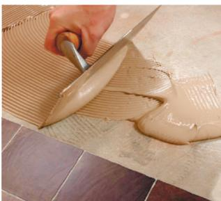
Предназначен для приклеивания фанеры перед укладкой паркета, линолеума на тканевой, джутовой или войлочной основе, ковровых покрытий, мозаичных и керамических облицовочных плиток (в том числе на печи и камины). Пригодные для нанесения основания: бетон, газобетон, штукатурка, асбоцемент, гипсовые, фанерные и прессованные минерально-волокнистые плиты и т.д.
