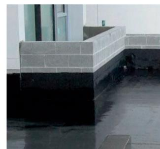
Приклеивание рулонных кровельных и гидроизоляционных материалов, полимерных изоляционных плёнок, лент, тепло- и звукоизоляционных материалов к металлическим и бетонным основаниям. Обмазочная гидроизоляция бетонных поверхностей фундамента, деревянных конструкций. Обладает высокой клеящей способностью, стойкостью к низким температурам.
