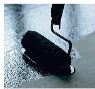
Грунтование металлических и бетонных поверхностей, цементно-песчаных стяжек перед нанесением обмазочной гидроизоляции, наплавлением рулонных кровельных материалов. Обладает быстрым временем высыхания, высокой проникающей способностью в поры основания, эффективно пропитывает и обеспыливает поверхность для наилучшей адгезии.
