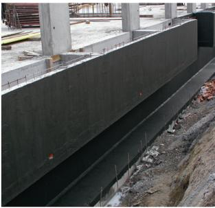
Обмазочная гидроизоляция бетонных поверхностей, элементов фундамента, внешних деревянных конструкций, подвалов, антикоррозионная защита трубопроводов и других коммуникаций, находящихся в условиях повышенной влажности или в грунте, а также для защиты от гниения и поражения грибом деревянных конструкций.
