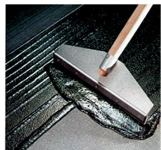
Гидроизоляция бетонных конструкций, заделка трещин и швов при кровельных работах, защита металлических поверхностей от коррозии, создание шумопоглощающего и виброизолирующего покрытия вентиляционных шахт, воздухопроводов, тонкостенных конструкций, кузова автомобиля и др.
