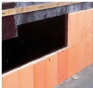
Приклеивание теплоизоляционных плит из экструдированного пенополистирола или пенопласта к бетонным, металлическим, деревянным и другим основаниям, а также для склеивания плит между собой.
